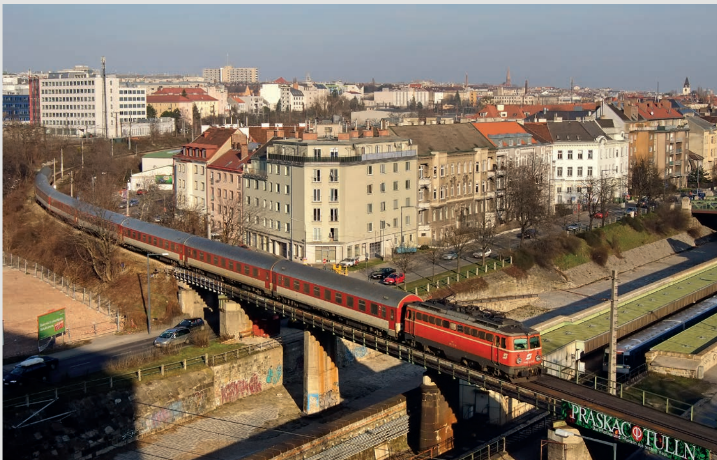
Die eingleisige Schleife Penzing – Abzweigung Wien Hütteldorf 1 übersetzt auf Höhe der ehemaligen Stadtbahnhaltestelle Unter St. Veit (heute eine Haltestelle der U4) das Wiental. Die Eisenträgerbrücke wird am 24.02.2008 von der 1142 623 mit dem IC 403 (Wien Westbahnhof – Košice) befahren (NF).
