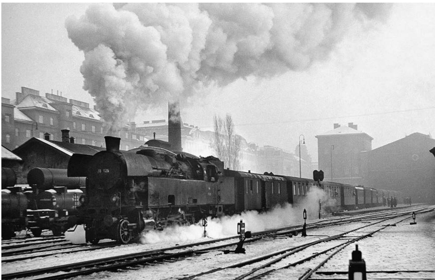
**Bild 206:** Am 26. Jänner 1957 verläßt die bereits mit Giesl-Ejektor und Witte-Windleitblechen ausgestattete 78.625 mit einem langen Personenzug denselben Bahnhof.
