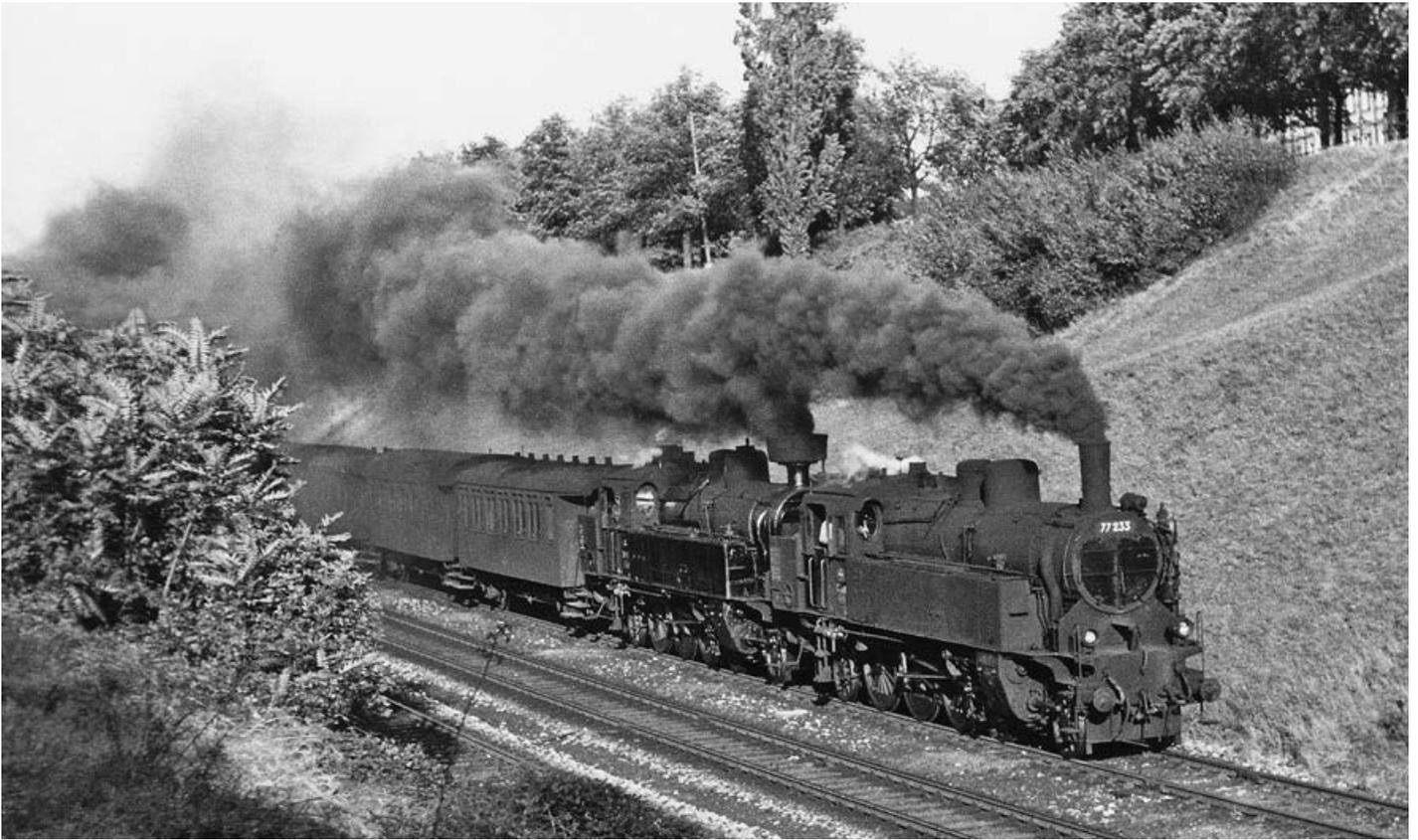
**Bild 188:** Von den 1939 umgezeichneten 85 BBÖ-629ern verblieben zum Kriegsende 68 im Land. Zwei waren nicht mehr aufbauwürdig, zehn weitere gab die MÁV 1950 im Zuge eines Loktausches zurück. Diese nun 76 mit 15t Achsdruck und 90 km/h zugelassener Höchstgeschwindigkeit vielseitig verwendbaren Tenderloks trugen fürderhin die Hauptlast des dampfgeführten Reiseverkehrs. 77 233 dampft mit einer Schwesterlok 1952 im Meidlinger Einschnitt südwärts.
