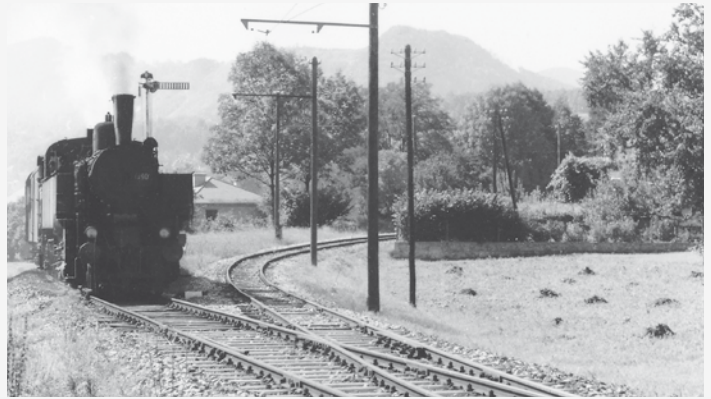
Ausbindung der Lokalbahnstrecke in Gmunden-Traundorf nach dem Umbau auf Dreischienengleis am 26.8.1963 mit Dampflokk 93.1390. Foto: Deutner
