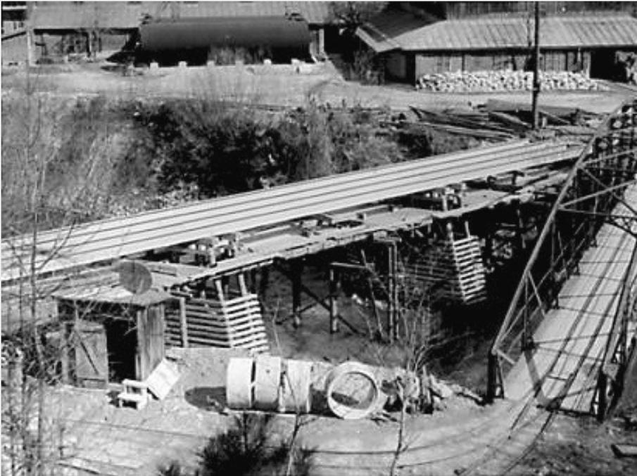
Die beiden Brücken über die Schwarza im Betriebsgelände. Rechts die Brücke der betriebs-internen Rollbahn, links die im Bau befindliche Brücke für die 760mm Strecke. Sammlung: N. Toplitsch
