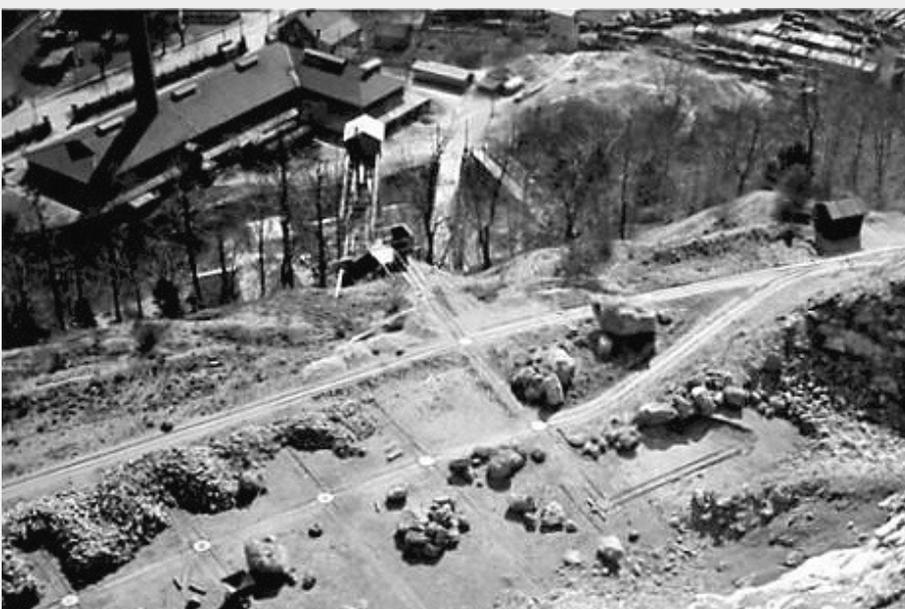
Oberhalb des Kalkwerks mit Blick auf die beiden Brücken und auf eine, mit einem Turm versehene Förderbrücke und einen Abwurf-schacht, gab es einen Lagerplatz, auf dem offensichtlich eine besondere Qualität der Rohsteine gelagert wurde. Sieben Drehscheiben und eine Linksweiche zum Hauptgleis sind zu sehen. Direkt an der Geländekante dürfte sich eine Rolle, also eine Materialabwurfstelle befinden haben.
