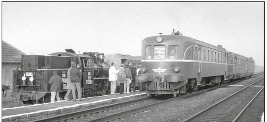
Die Einfädelung in die Strecke Hermannstadt – Kronstadt (KBS 200) der „großen Eisenbahn“ bei Moichen im Jahre 1992: Eine praktische und ressourcenschonende Lösung für die letzten sieben Kilometer der Kleinbahnstrecke. 764.205 wirkt bescheiden neben den Malaxa-Triebwagen. Noch stehen beide Spurweiten nebeneinander ... (Șerban Lacrițeanu)
