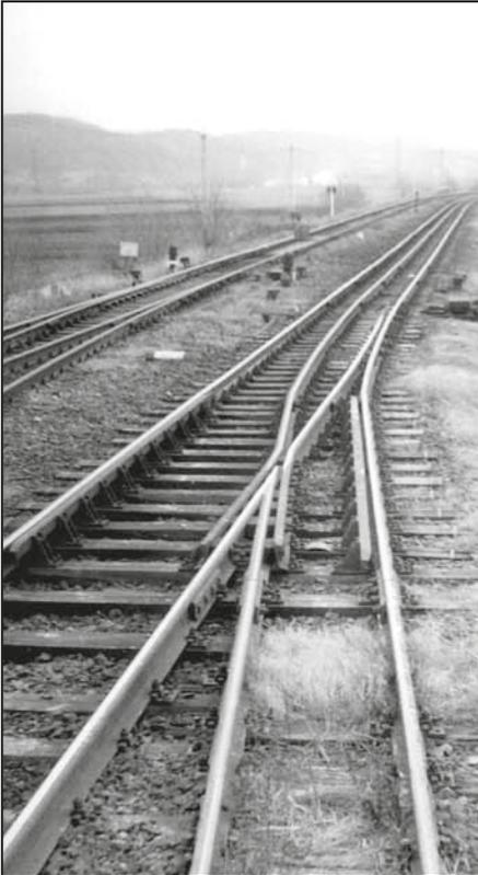
Blick auf die Einfädelung der Schmalspurstrecke in die Hauptstrecke. Etwa 300 Meter vor dem Schmalspurbetriebswerk in Hermannstadt fädelt die „kleine Bahn“ wieder aus. Die Dreigleisigkeit ist in vollem Umfang erhalten. (Șerban Lacrițeanu)
