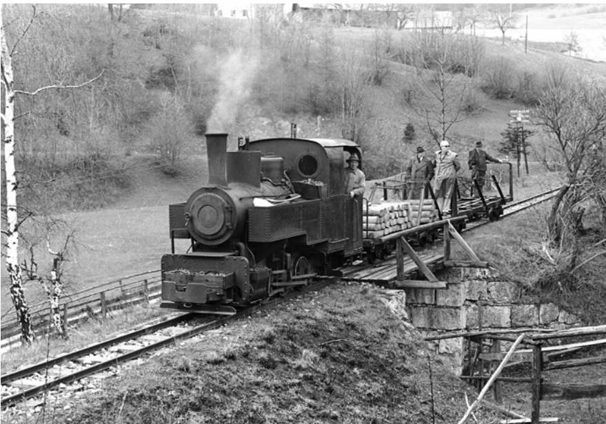
Abb. 6. Der Zug am selben Tag knapp vor dem Viadukt auf der Brücke über einen Wirtschaftsweg (km 0,41). Von dieser Brücke ist nur ein Widerlager erhalten geblieben. Heute führt an dieser Stelle der Steirische Semmeringbahn-Wanderweg von Semmering nach Mürzzuschlag vorbei. (Foto: Alfred Luft)
