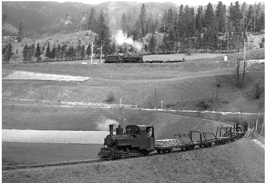
Abb. 8. Nach dem Überqueren der Alten Reichsstraße ist der Waldbahnzug anlässlich der „Abschiedsfahrt“ am 6. Mai 1958 auf der Strecke über den heute noch bestehenden, so genannten „Steinhauser Damm“ unterwegs. Auf der Südbahn (im Hintergrund) werden zu dieser Zeit die Masten für die Elektrifizierung der Strecke gesetzt. Die Dampflokomotive 257.602 ist mit einem Bauzug unterwegs. (Foto: Alfred Luft)
