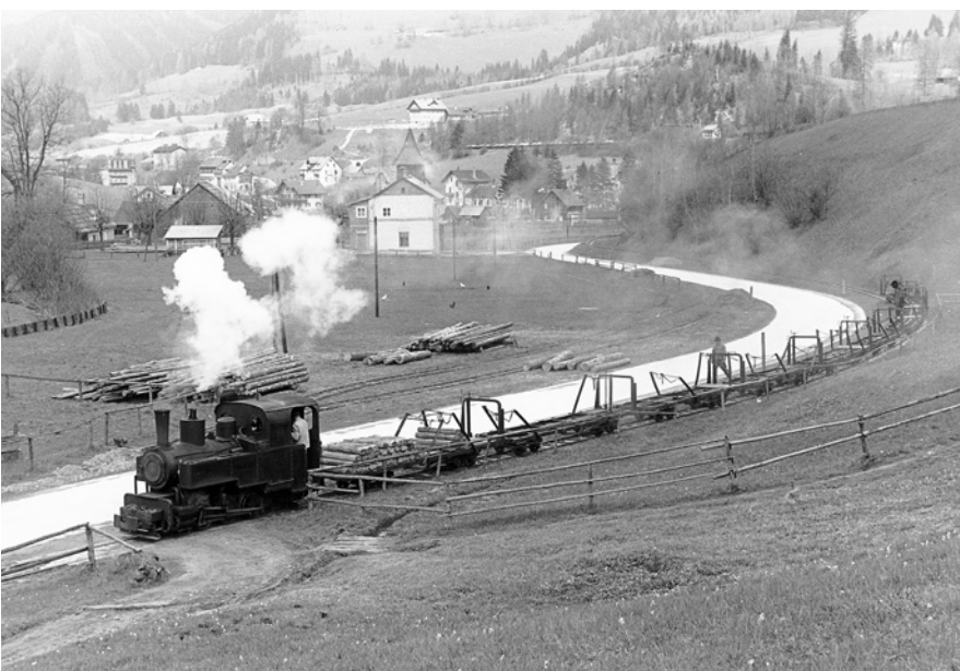
Abb. 85. Derselbe Zug kurz vor dem Lanckoroński'schen Forsthaus (km 1,1) in Steinhaus. Auf der anderen Seite der Straße sind die beiden Stutzgleise sichtbar, im Hintergrund ist das Rüsthaus der Feuerwehr Steinhaus zu erkennen. (Foto: Harald Navé/Archiv VEF)
