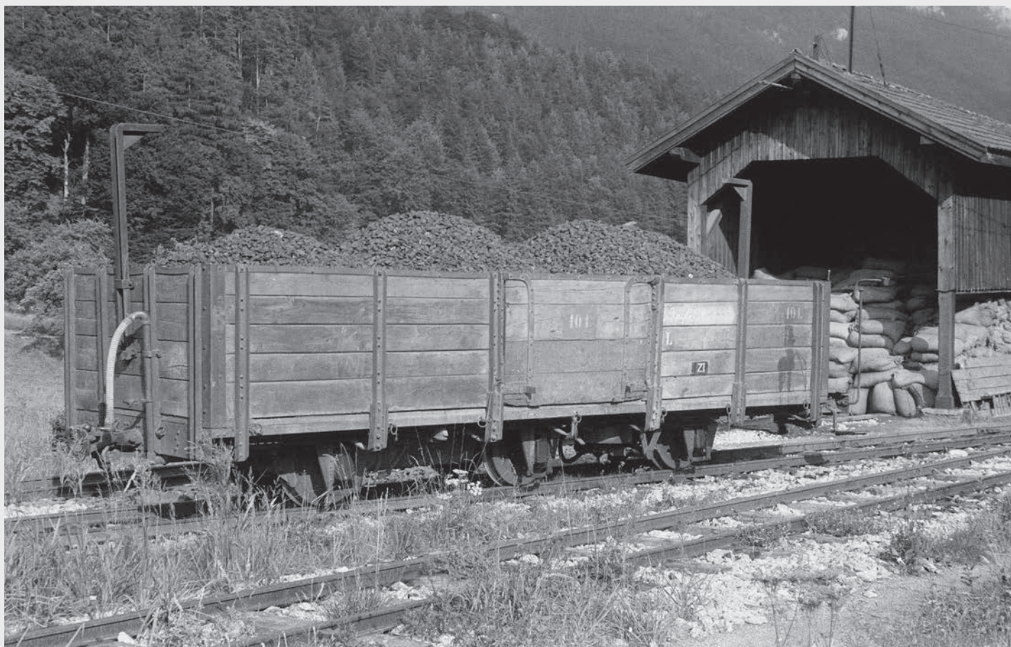
Im Laufe von 42 Einsatzjahren hatte der zuvor abgebildete Wagen bereits einige Änderungen erfahren. Er trug zum Aufnahmezeitpunkt die Nummer 101, das Bremserhaus war längst entfernt worden und auch die Bretterwände wurden getauscht. (Alfred Luft, 16. Juli 1955)
