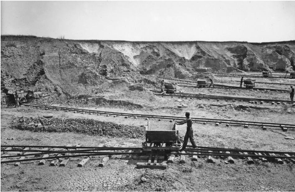
In der Grube selbst wurde der Ton ( Tegel ) mittels handgeschobener Kipploren zum elektrischen Schrägaufzug gebracht, wo er in die Feldbahn umgeladen wurde. Das Bild entstand 1933 ( Sammlung Lafarge Zementwerke GmbH ).
