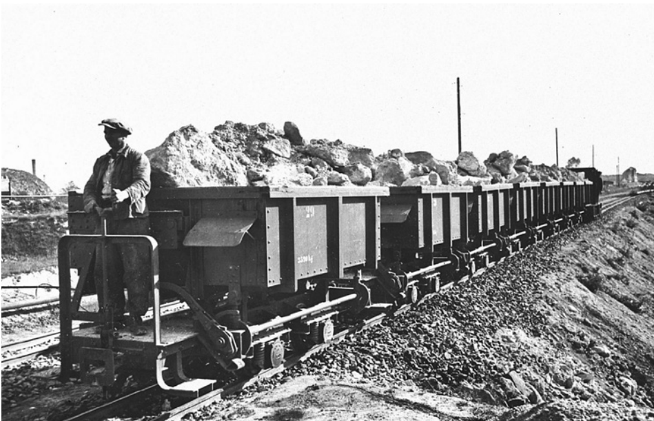
Zur Tegelbeförderung wurden nicht nur Loren, sondern auch Seitenkipper eingesetzt. Hier wird ein Zug mit beladenen Seitenkippern von der Tongrube ins Werk geschoben, datiert mit 1940er Jahre ( Sammlung Stadtmuseum Mannersdorf ).
