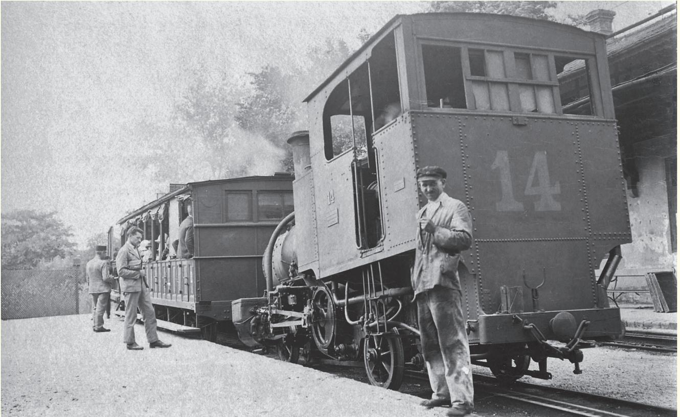
Die frühere Lok Nr. 2 der Arth-Rigi-Bahn wurde im Jahr 1908 als Lok Nr. 14 von der Rigibahn übernommen. Sie besaß eine Achse für das Antriebszahnrad hinter der ersten Tragachse, die Zylinder waren vorne am Rahmen angeordnet. Die Lok gelangte 1917 zur Schwabenbergbahn in Budapest, wo im Bahnhof Városmajor dieses Foto aufgenommen wurde. Sammlung Lothar Rihosek
