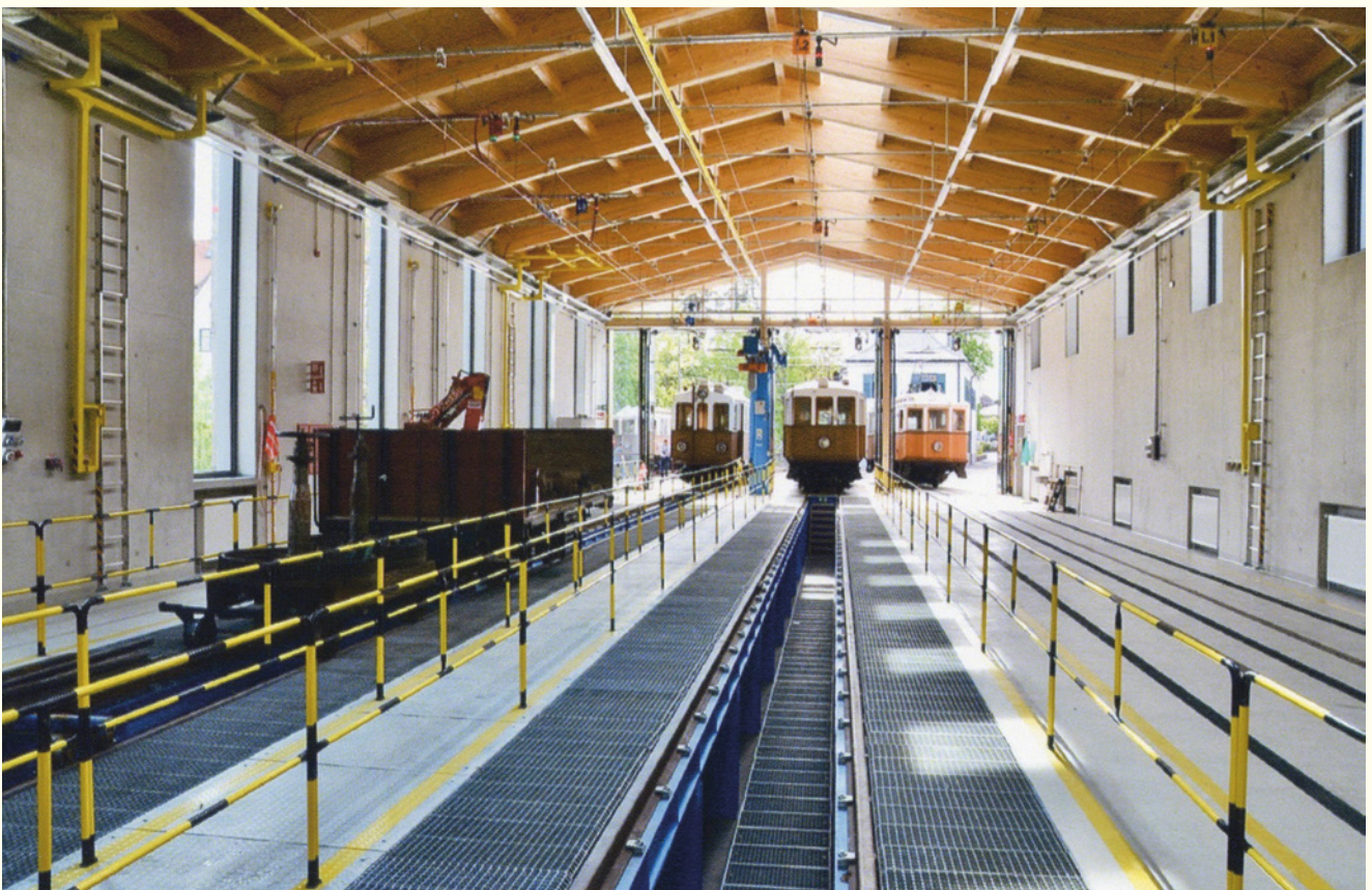
Das Innere der neuen Triebwagenhalle und Werkstätte.
