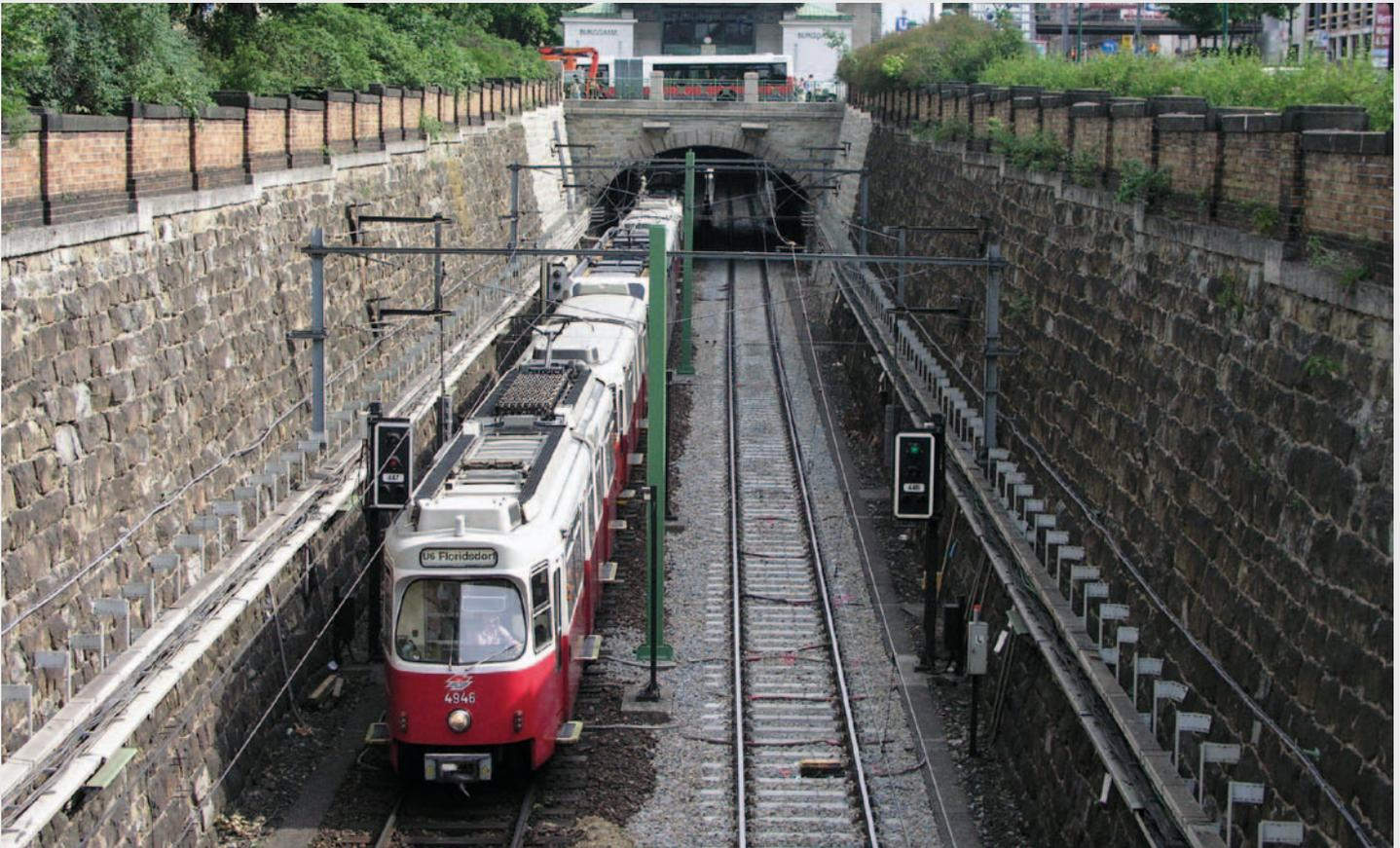
2005 wurde die Strecke zwischen den Stationen Burggasse-Stadthalle und Thaliastraße erneuert. Das Gleis 2 besitzt bereits Betonschwellen, und neue Masten stehen zwischen den Gleisen. Die aus der Anfangszeit des elektrischen Betriebs stammenden Querjoche und Abspannwerke, die diesen Streckenabschnitt so prägten, standen nicht mehr lange in Verwendung, als der E<sub>6</sub> 4946 zur Thaliastraße fuhr. Foto: Martin Ortner, 14. Juni 2005.
