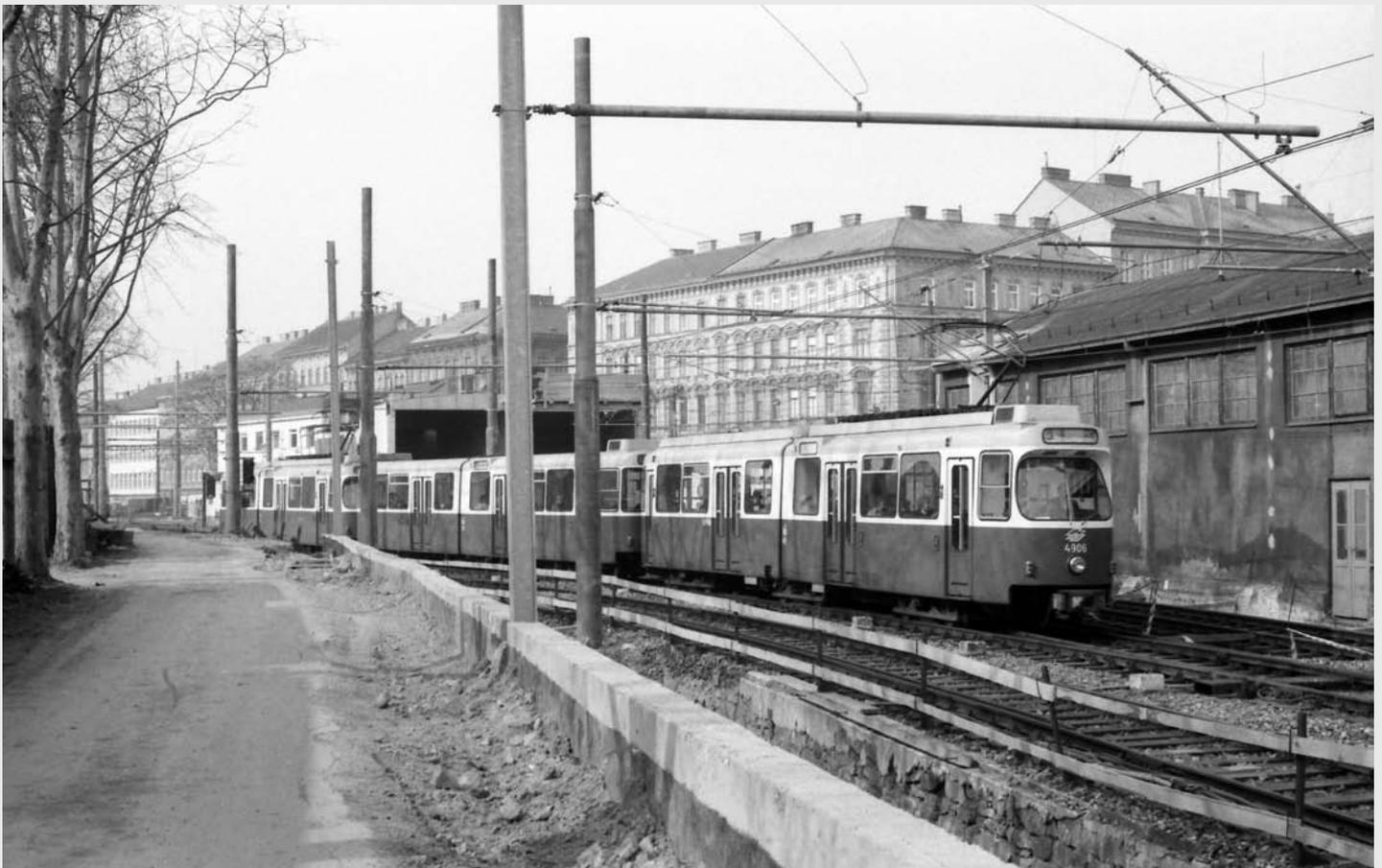
Im Zuge der Errichtung der Station Michelbeuern-Allgemeines Krankenhaus wurde der Sockel des Stationsgebäudes bereits fertiggestellt. Für die Errichtung des Bahnsteiges wurde das mittlere Gleis, auf dem hier der E<sub>6</sub> 4906 mit einem Drei-Wagen-Zug der Linie G fährt, entfernt. Foto: Archiv Wögerer-Wojnar, 22. Mai 1984.
