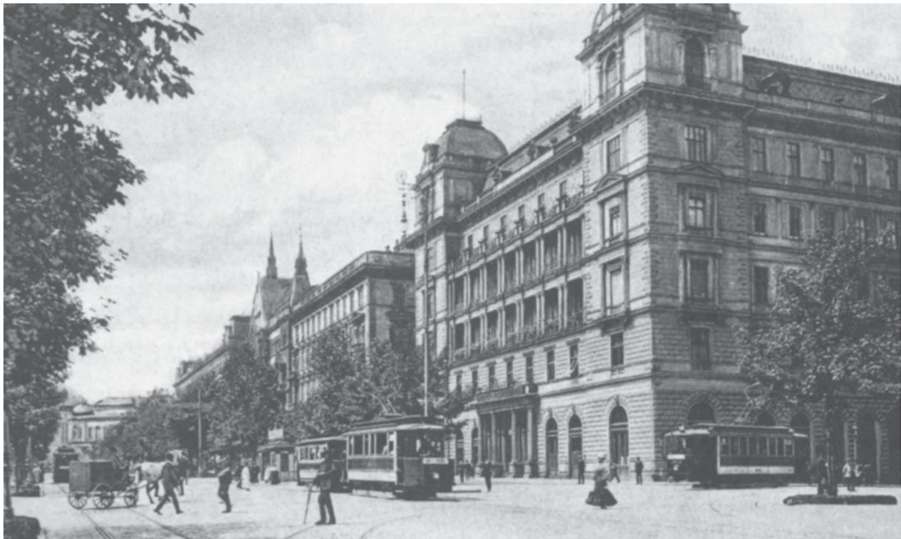
Ein Zug der Linie E<sub>K</sub> fährt am Schottenring in Richtung Kai. Man erkennt den 1902 bei der Waggonfabrik Ringhoffer in Smichov gebauten G 975, der gerade die Börsekreuzung überquert. Rechts kommt ein Zug der Linie 40 aus der Wipplingerstraße, es ist der 1907 von der Grazer Waggonfabrik geliefert G<sub>2</sub> 2071, welcher 1963 ausgemustert wurde. Foto: Sammlung Hlavač, 1909.
