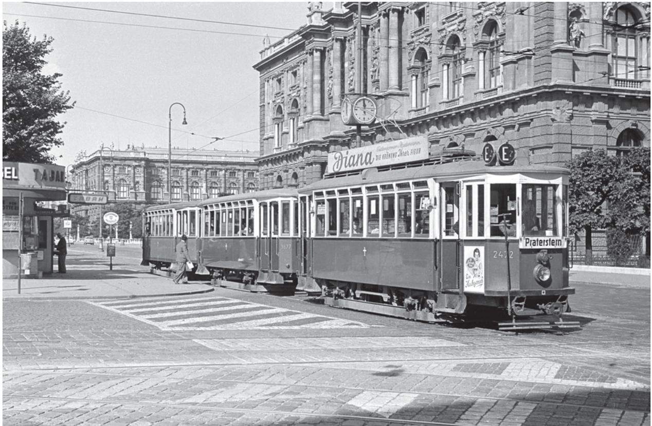
Der K 2472 (Bj. 1914, Nesselsdorf) überquert mit den zwei k3-Beiwagen 3677 (Bj. 1919, Stauding) und 3648 (Bj. 1916, Simmering) die Babenberger Straße auf seiner Fahrt zum Praterstern. Der Triebwagen zeigt sich im Zustand nach dem Umbau auf Magnetschienenbremse und ELIN-Dose und gummigefassten Stirnfenstern, bei den Beiwagen hatte der 3677 noch seine gewölbte Seitenwand, jedoch ohne Scheuerleiste.
