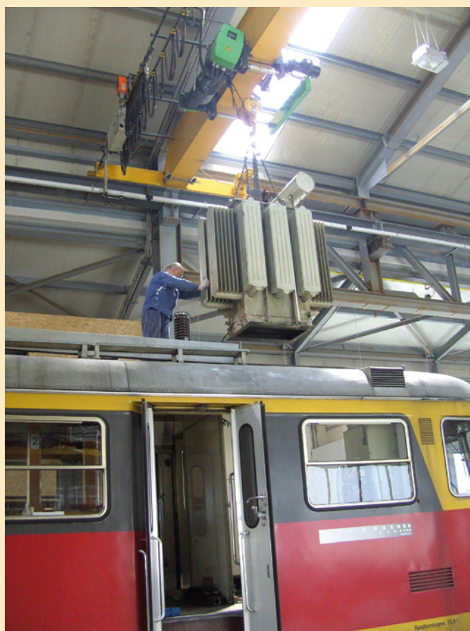
Einbau des neu aufgearbeiteten Transformators in der Halle in Dornbirn. (Foto: Robert Köfler)
